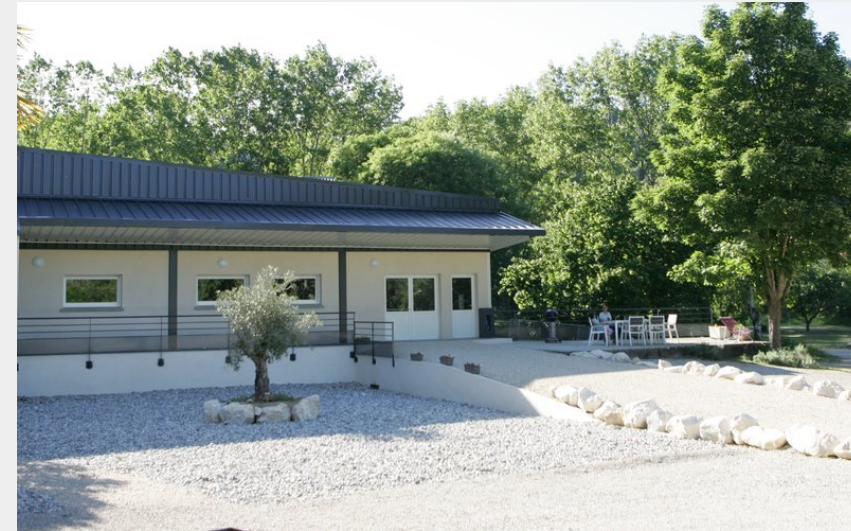
Crédit photo : Vue extérieure du bâtiment (Lubac Fabrice)
